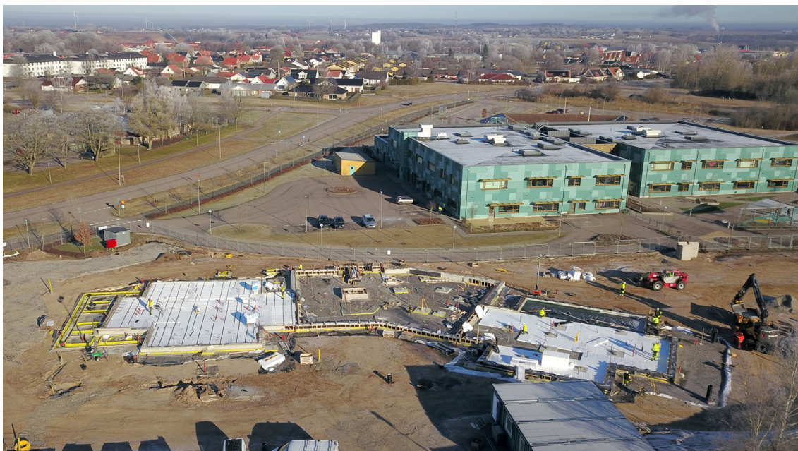
Bygget av Nya Sjöskulla förskola är påbörjat.
