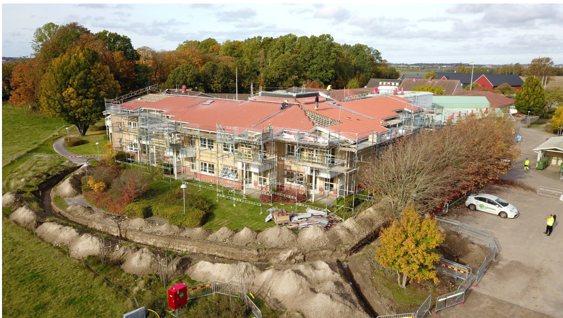
På Randerslunds äldreboende i Ränneslöv pågår ett omfattande underhållsarbete.
