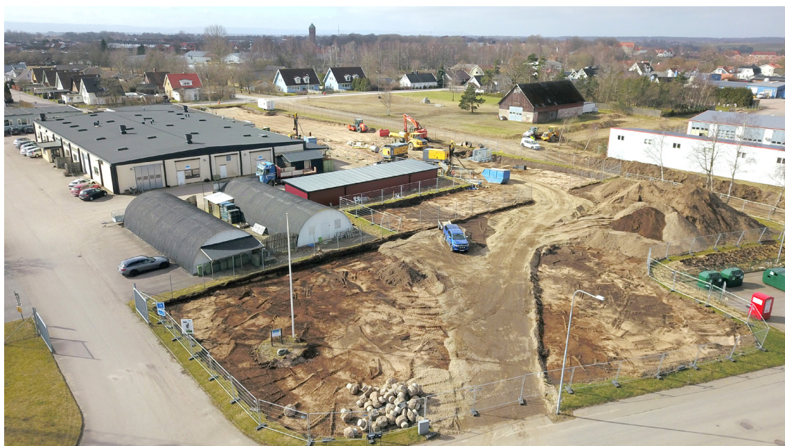
Hemvisten – arbetet med bolagens egna lokaler för administration och drift har påbörjats.
