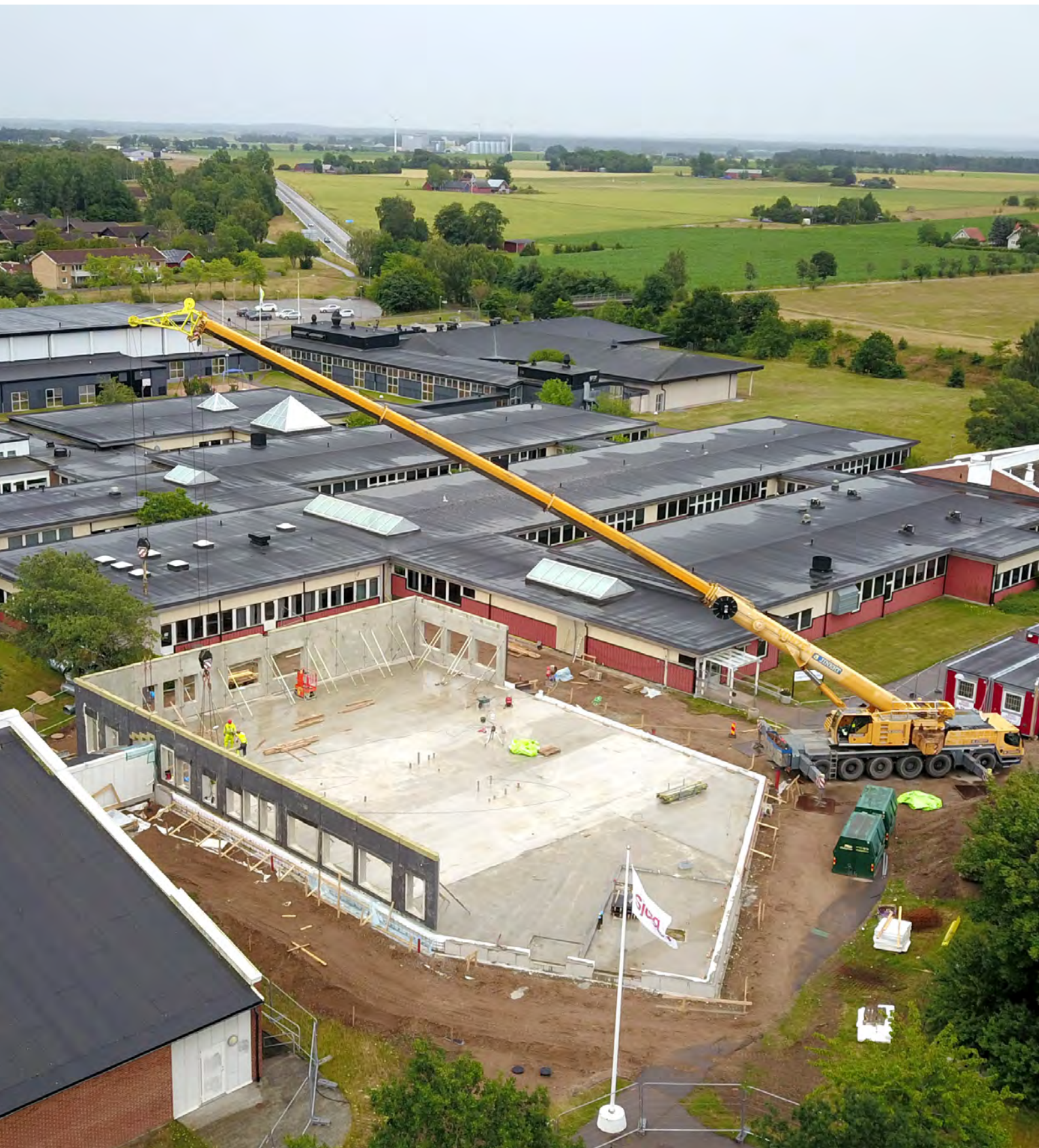
Återuppbyggnad av Campus Laholm.
